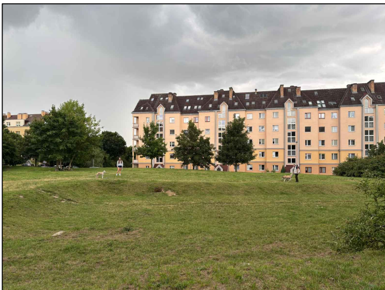
Fot. 6. Widok na południową skarpę wgłębnika i szpaler klonów
